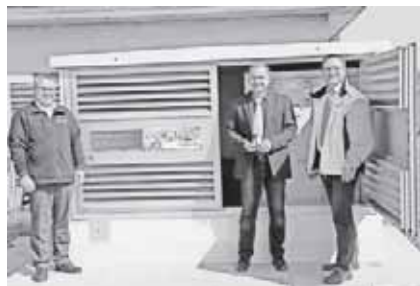
Untertitel Bild: Pflanzenöl als Isolator in Transformatoren – hier in Sasbach in der neuen Ortsnetzstation an der Weinstraße. v.l. Reinhard Jäger, Jürgen Scheiding, Andreas Götz
